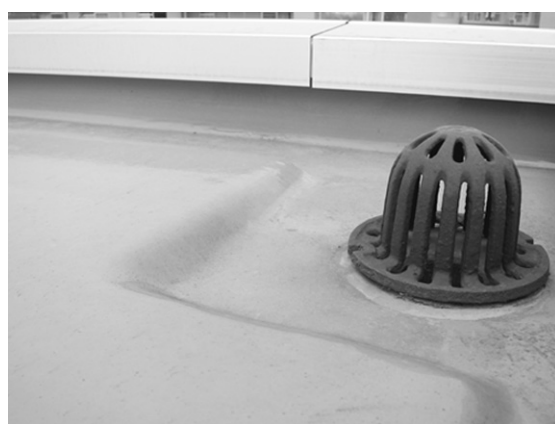
写真1 出隅、入隅部にも十分な膜厚を確保されているウレタン塗膜防水層の施工例
